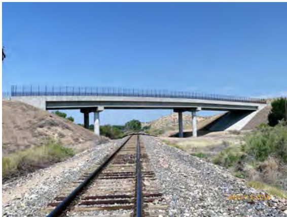
K-16-CI (Rio Grande Viaduct)
