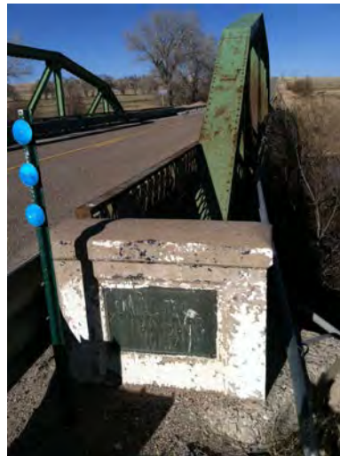
Purgatoire River Bridge, 2014
